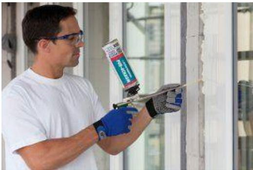
Reparaturarbeiten oft auf Polyurethan-Schaumdosen (PUR-Schaumdosen) zurück, die gern zum Dämmen, Dichten und Isolieren eingesetzt werden, die aber wegen ihrer gesundheitsschädlichen Inhaltsstoffe als gefährliche Abfälle (Sonderabfall) einzustufen sind. Sie dürfen
