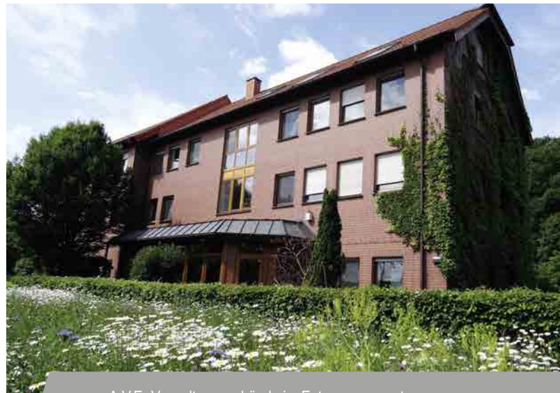
A.V.E.-Verwaltungsgebäude im Entsorgungszentrum
