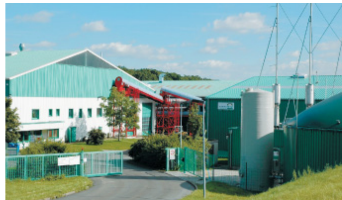
Das Nieheimer Kompostec-Kompostwerk: Hier werden die Bioabfälle professionell zu Kompost verarbeitet.
