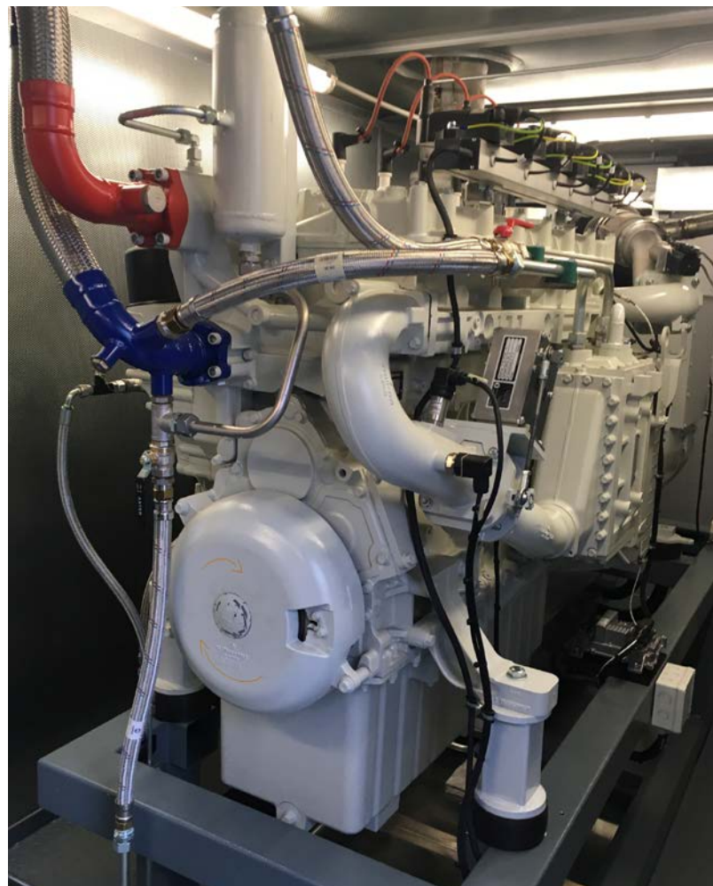
Noch rechtzeitig vor Jahreswechsel installiert: Das verkleinerte BHKW zur Deponiegasverstromung und Abwärmenutzung
