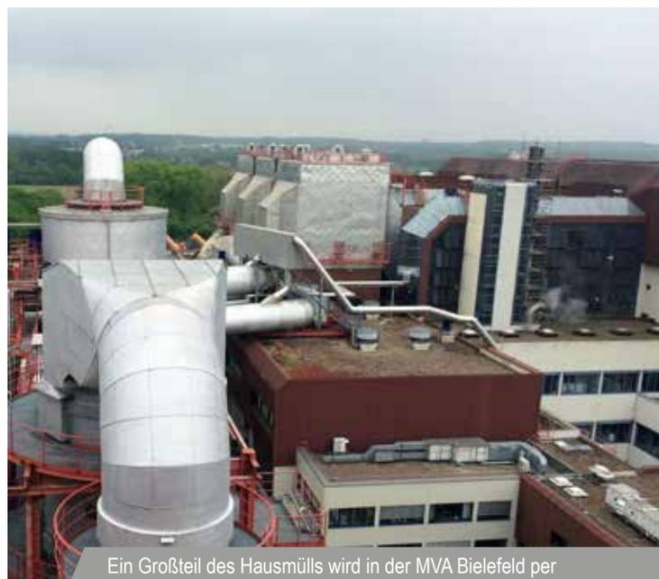
Ein Großteil des Hausmülls wird in der MVA Bielefeld per Kraft-Wärme-Kopplung thermisch verwertet.
