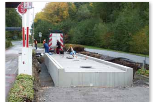
Im Oktober war Baubeginn für die vierte Waage
