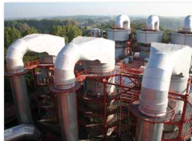
Effiziente 8-stufige Rauchgasreinigung in der MVA Bielefeld
