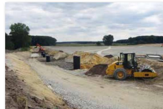
Bau der neuen Inertstoffdeponie (DK0) und des Fernwärmenetzes zur klimafreundlichen Nutzung der Motorabwärme aus dem benachbarten Blockheizkraftwerk, das der Deponiegasverstromung dient. (Stand August 2013)
